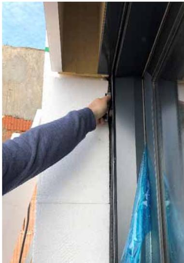
c) Wir montieren die Leibung mithilfe von Schaum-Klebstoffen (z. B. STYRO PRO TYTAN). Der Klebstoff wird auf die Leibung in Form eines Rahmens aufgetragen. Man muss darauf achten, dass die Leibung in vertikaler Position bleibt (wir überprüfen mithilfe einer Libelle oder durch Abmessen der gleichen Fläche des übrig gebliebenen sichtbaren Teils des Fensterrahmens).
