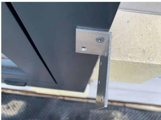
c) Die Leibung legen wir an den Fensterrahmen so an, dass sie in den vorbereiteten Winkeln anliegt, und verankern sie mit Holzschrauben. Wir verankern das Gehäuse der Leibung im Inneren des Kastens und die eigentliche Leibung über die Winkel.
