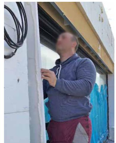
d) Es wird empfohlen, die Leibung im oberen Teil mit einer Holzschraube zu sichern, die wir über die Buchse der Führungsleiste in die Seitenwand des Kastens einschrauben (die Buchse soll vorgebohrt werden).
